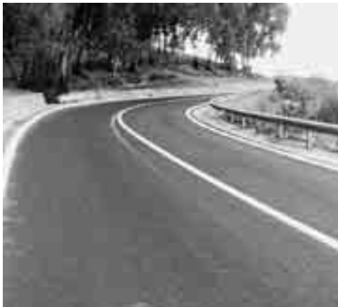
UN TRATTO DELLA STRADA RIAMMODERNATA
